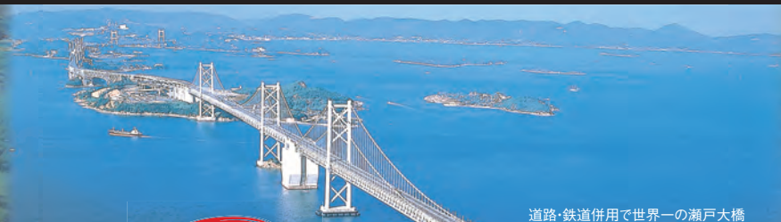
道路・鉄道併用で世界一の瀬戸大橋
